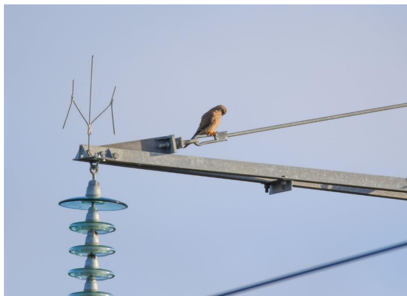
2 pav. Pelėsakalis tupi prie įdiegtų apsaugos priemonių - šakutė ir lėkštutė (M. Karlono nuotrauka).
