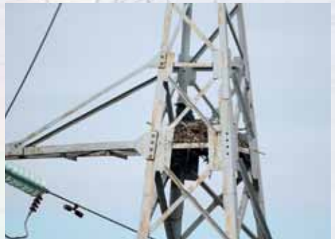
Krančiai neretai susisuka lizdus metalinėse atramos konstrukcijose
