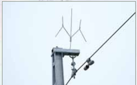
„Šakutė“ neleidžia paukščiui nutūpti virš laidų
