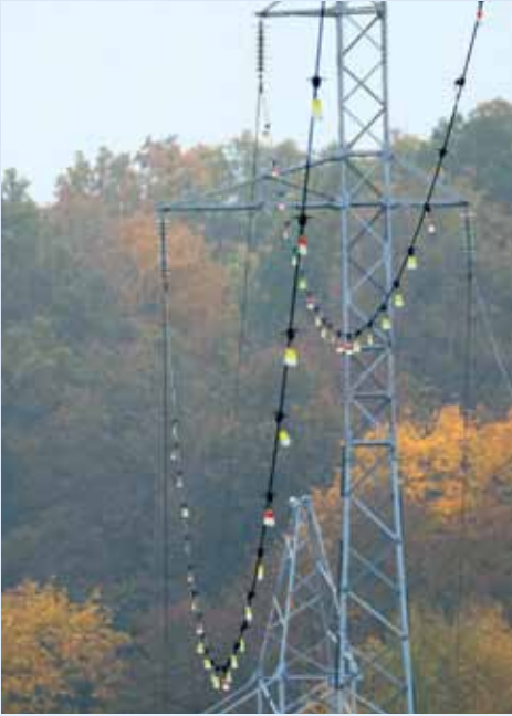
„Pakabukais“ padidintas aukštosios įtampos elektros perdavimo linijos matomumas Kaune prie hidroelektrinės
