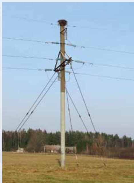
Baltųjų gandrų lizdas, sukrautas ant betoninės atramos
