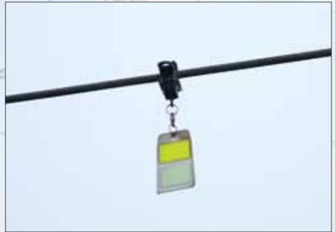
„Pakabuko“ konstrukcija sukurta taip, kad besisukdamas atspindėtų šviesą
