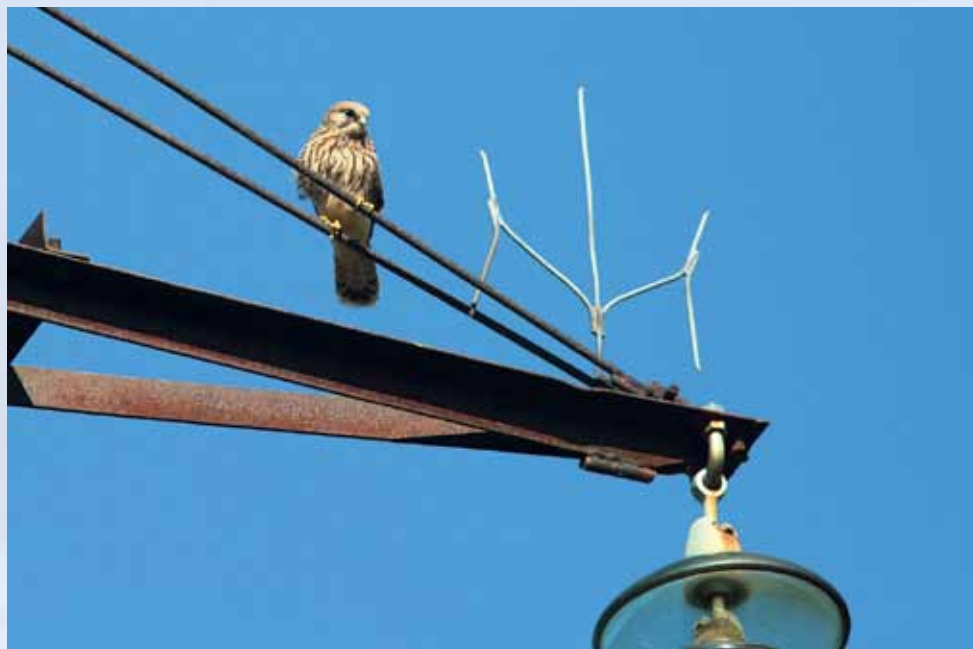
Paprastą pelėsakalio jauniklis ant elektros linijos atramos su „šakutės“ ir „lėkštutės“ tipo apsaugais
